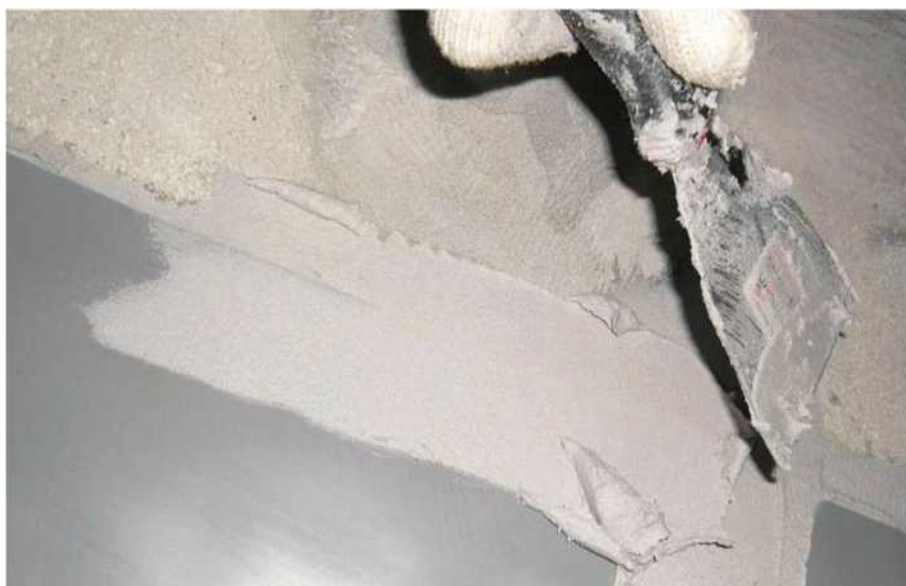
Рисунок 7.3.7 – Шпатлевание краев ленты клеем «ПенеПокси 2К»
