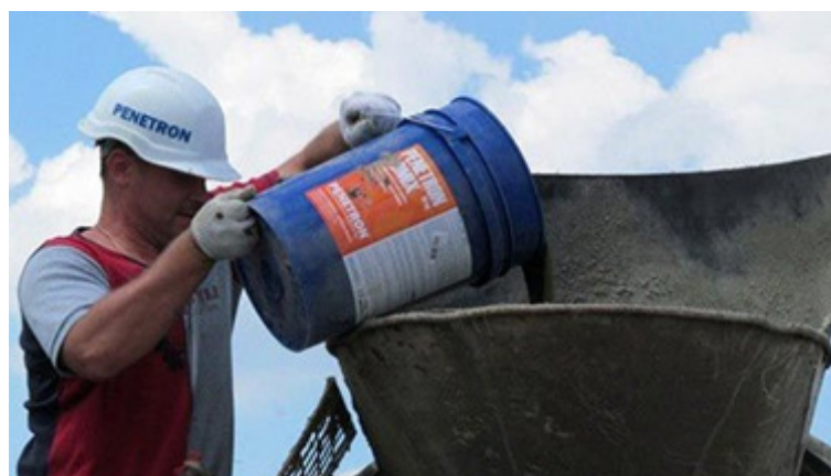
Рисунок 7.1.2 – Пример введения добавки «Пенетрон Адмикс» в автобетоновоз
