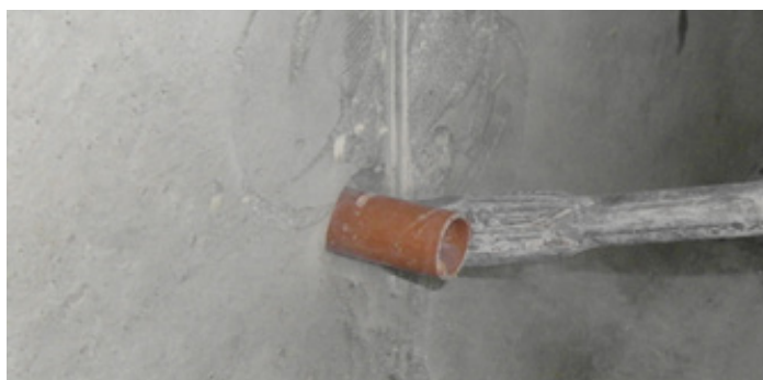
Рисунок 7.2.53 – Удаление пластиковой втулки
