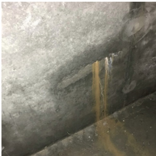
Рисунок 7.2.33 – Безнапорная течь
