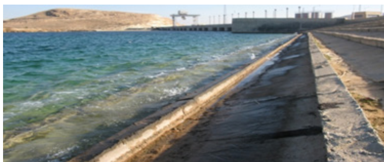
Рисунок 6.6 – Железобетонные крепления откосов грунтовых плотин:
