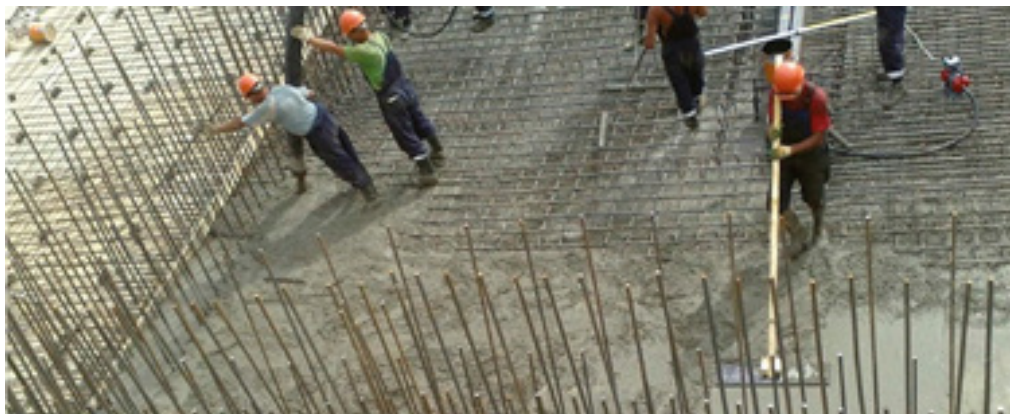
Рисунок 7.1.3 – Укладка бетонной смеси
