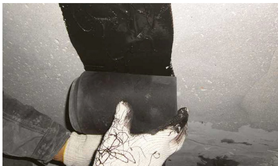
Рисунок 7.3.6 – Укладка ленты «ПенеБанд» на «ПенеПокси»
