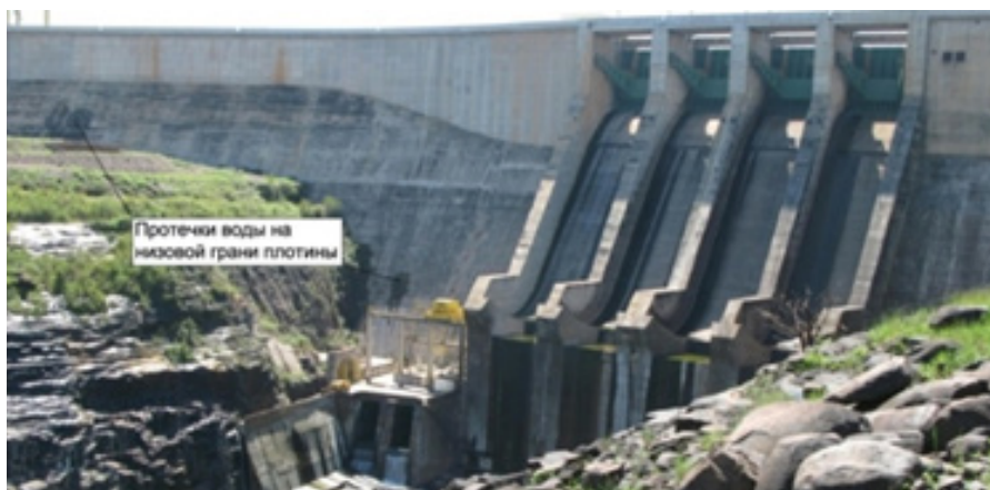
Рисунок 6.2.2 – Плотина из укатанного бетона
