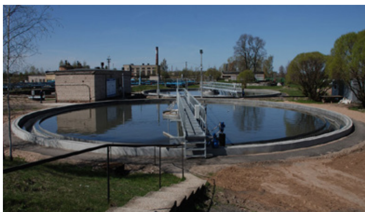
Рисунок 6.4.1 – Радиальный отстойник из монолитного железобетона: а – опорожненный; б – в период эксплуатации
