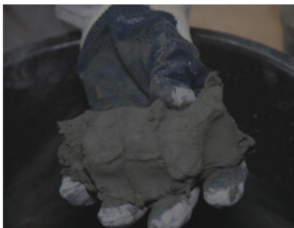
Рисунок 7.2.24 – Приготовление растворной смеси «Скрепа М500 Ремонтная»
