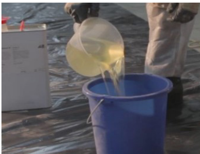
Рисунок 7.2.29 – Дозирование компонентов смолы
