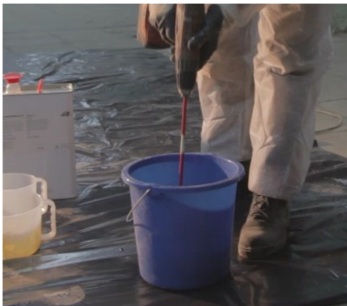
Рисунок 7.2.30 – Приготовление необходимого объема смеси компонентов смолы
