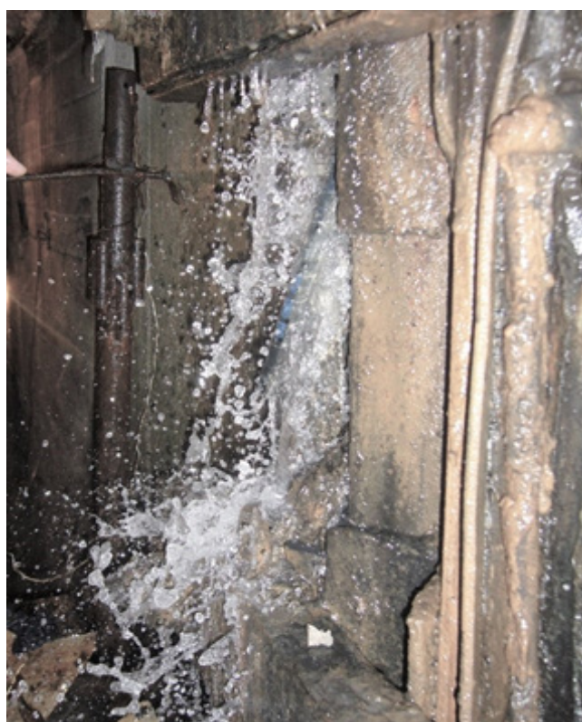
Рисунок 7.2.34 – Напорная течь
