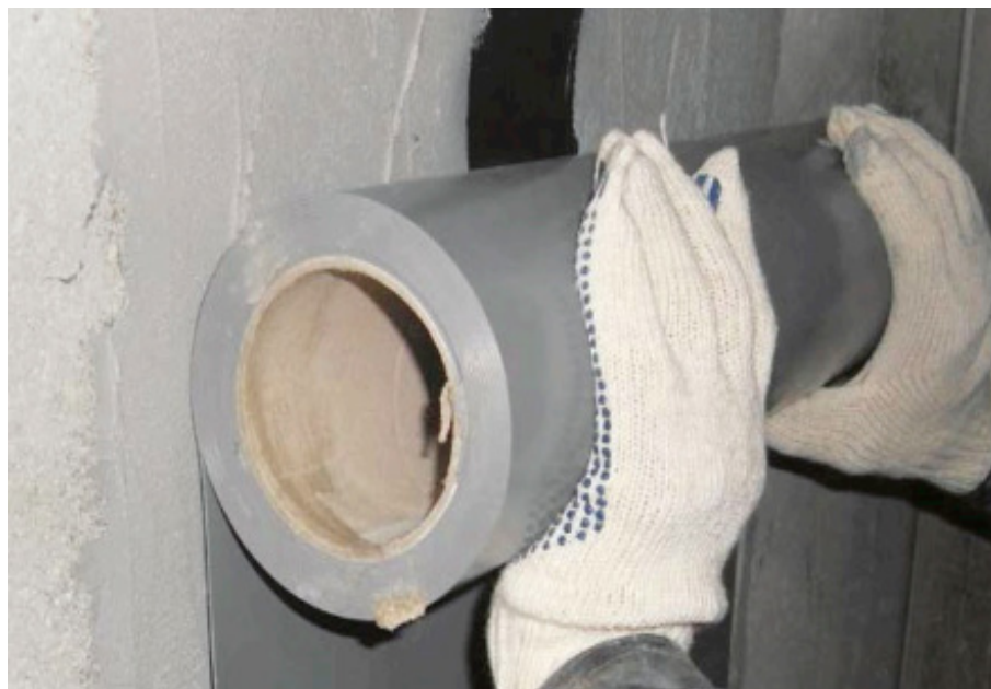
Рисунок 7.3.5 – Укладка ленты «ПенеБанд С» на «ПенеПокси 2К»
